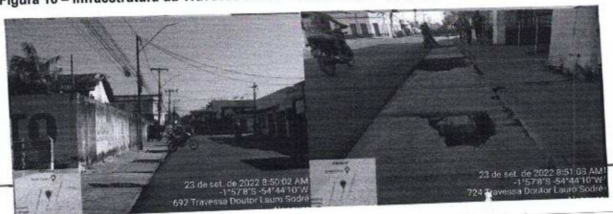
Figura 10 – Infraestrutura da Travessa Doutor Lauro Sodré - Alenquer/PA.
