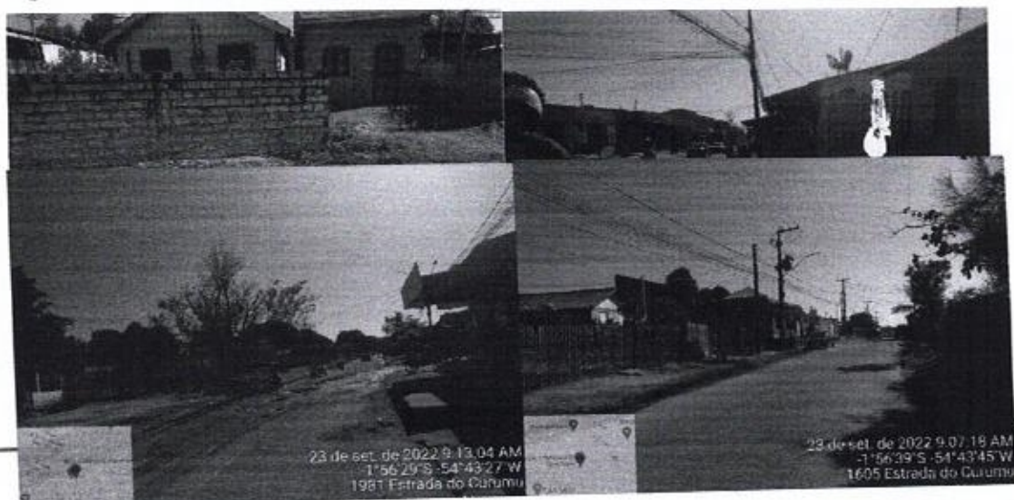
Figura 13 – Infraestrutura da Estrada do Curumu - Alenquer/PA
