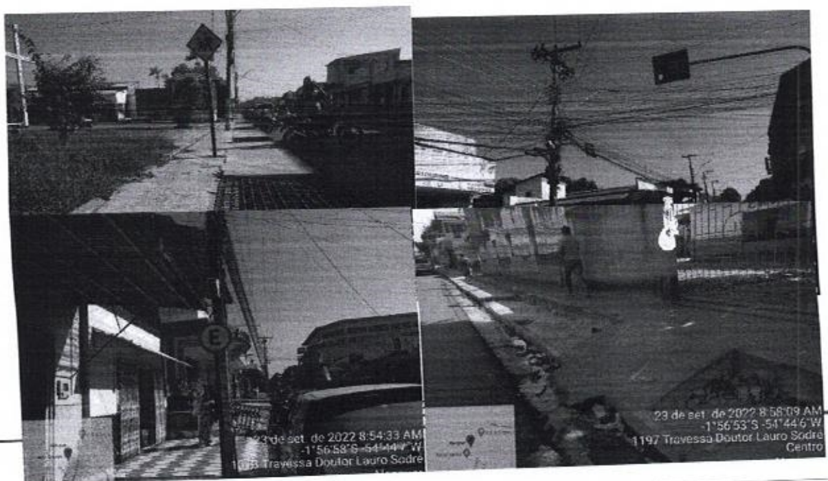
Figura 11 – Infraestrutura da Travessa Doutor Lauro Sodré - Alenquer/PA
